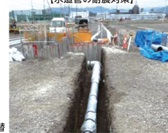
【水道管の耐震対策】
